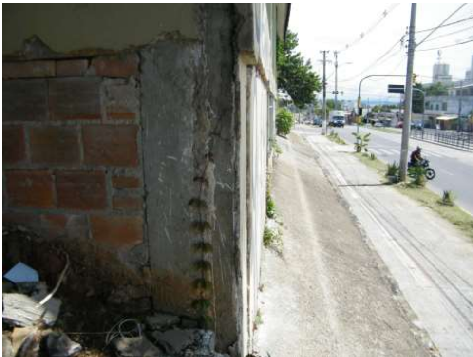
Foto 32 – Desaprumo e Desprendimento da Alvenaria.
