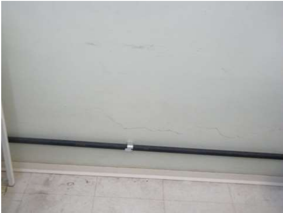
Foto 07 – Fissuras Devido Carregamentos Diferentes.
