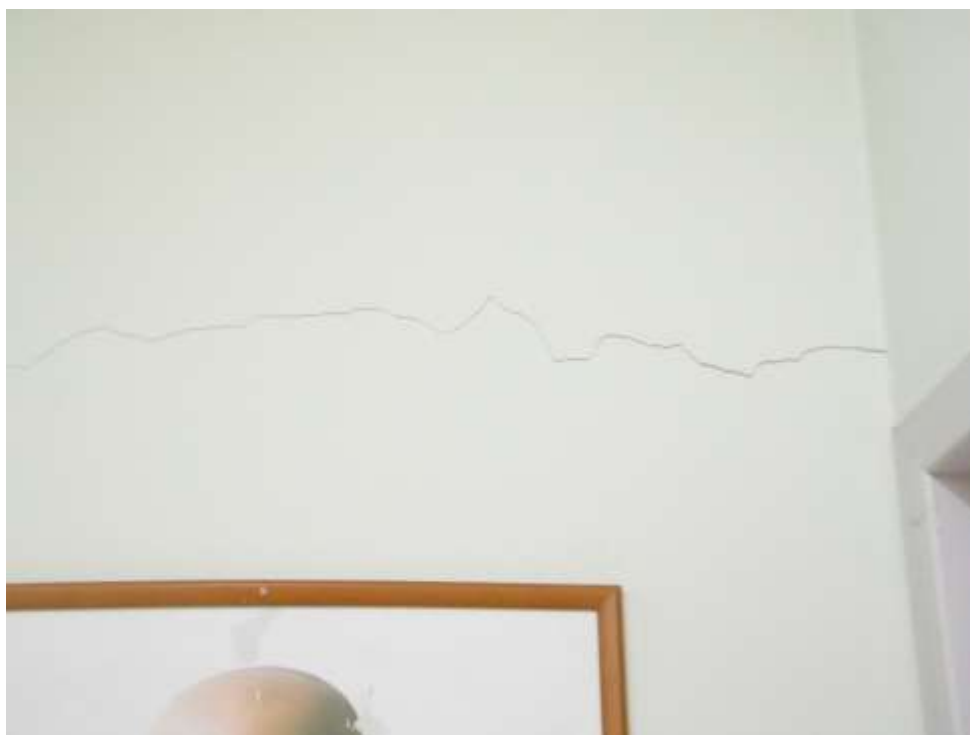
Foto 24 – Fissuras Devido Movimentação das Estruturas.
