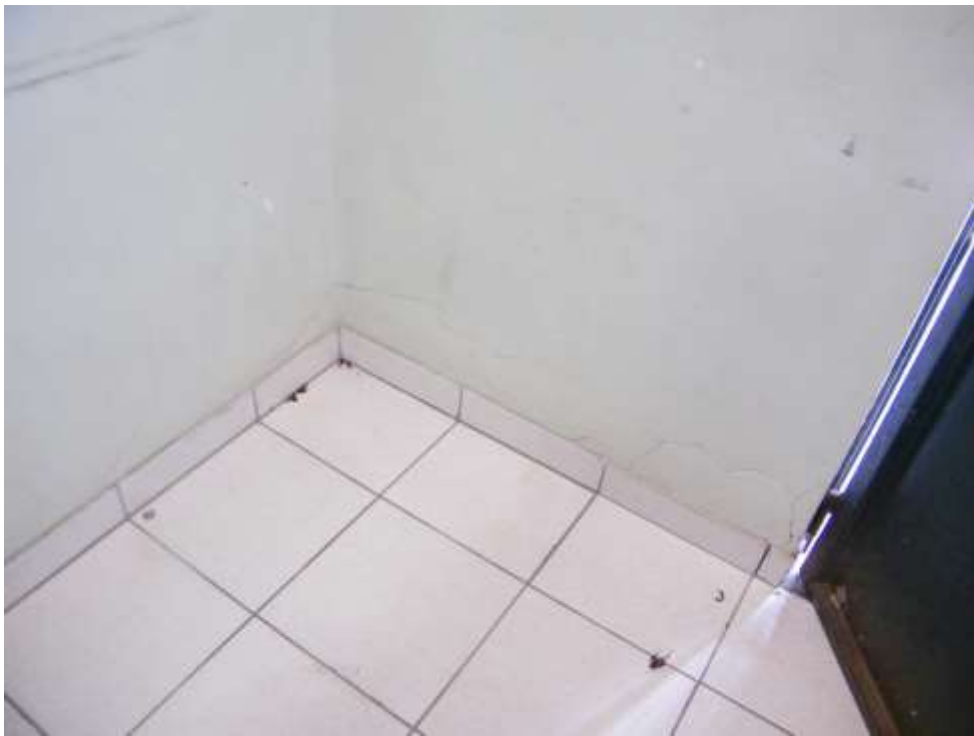
Foto 09 – Fissuras Característica Recalque na Fundação.
