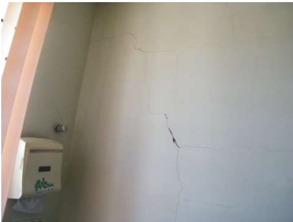
Foto 27 – Fissuras Devido Recalque das Fundações.
