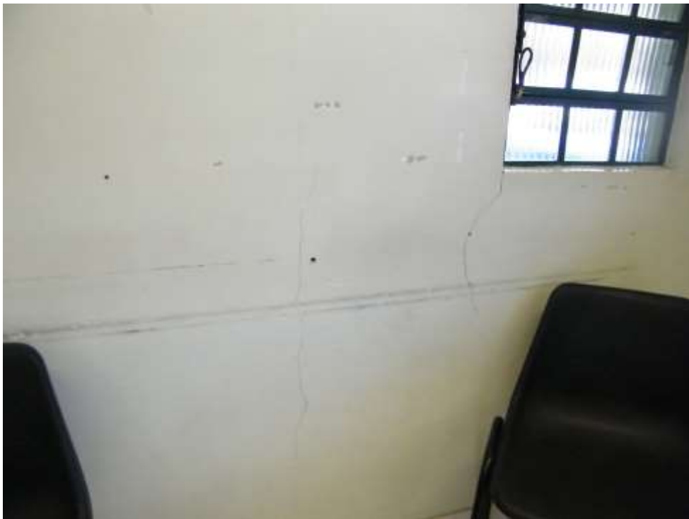
Foto 10 – Fissuras Característica Recalque na Fundação.
