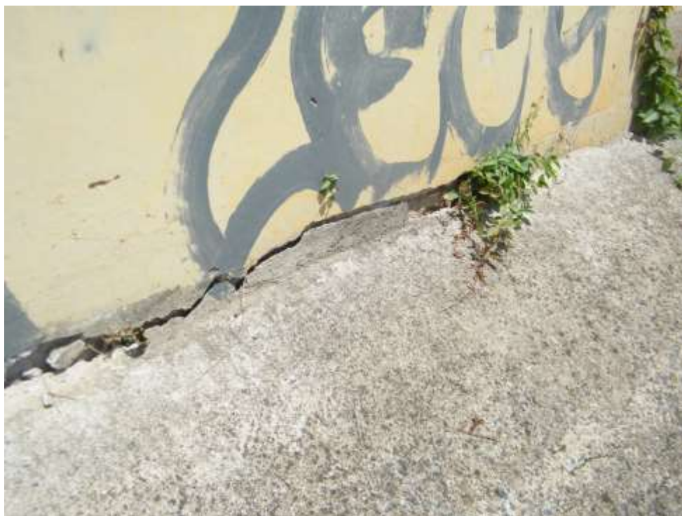
Foto 34 – Fissura Ocasionado pelo Recalque do Talude.
