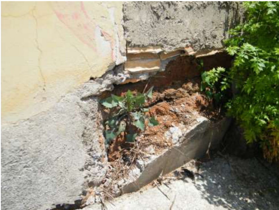
Foto 38 – Fissuras Ocasionado Pela Árvore Cinamomo e Recalque nas Fundações.
