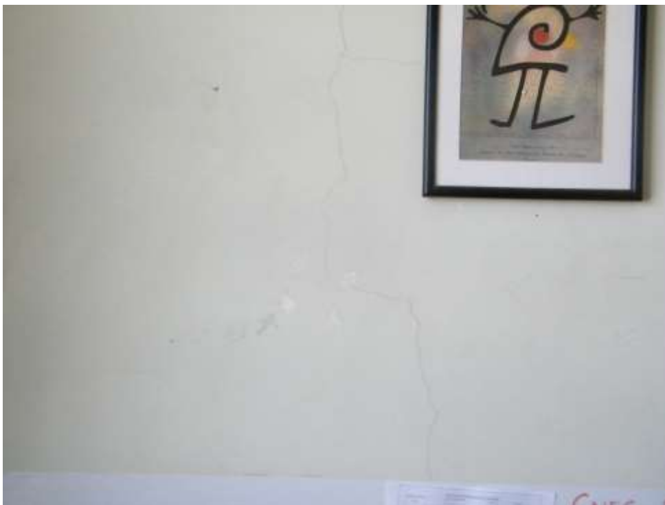
Foto 17 – Fissuras Característica Recalque na Fundação.
