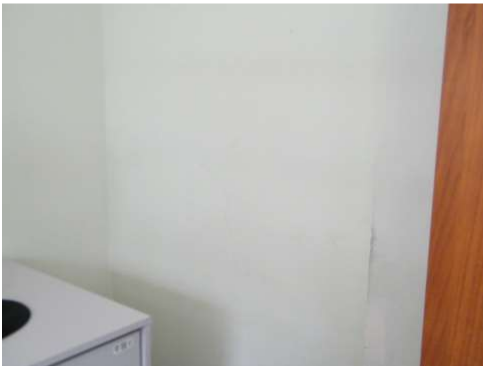
Foto 18 – Fissura Devido Dilatação Térmica dos Materiais Diferentes.
