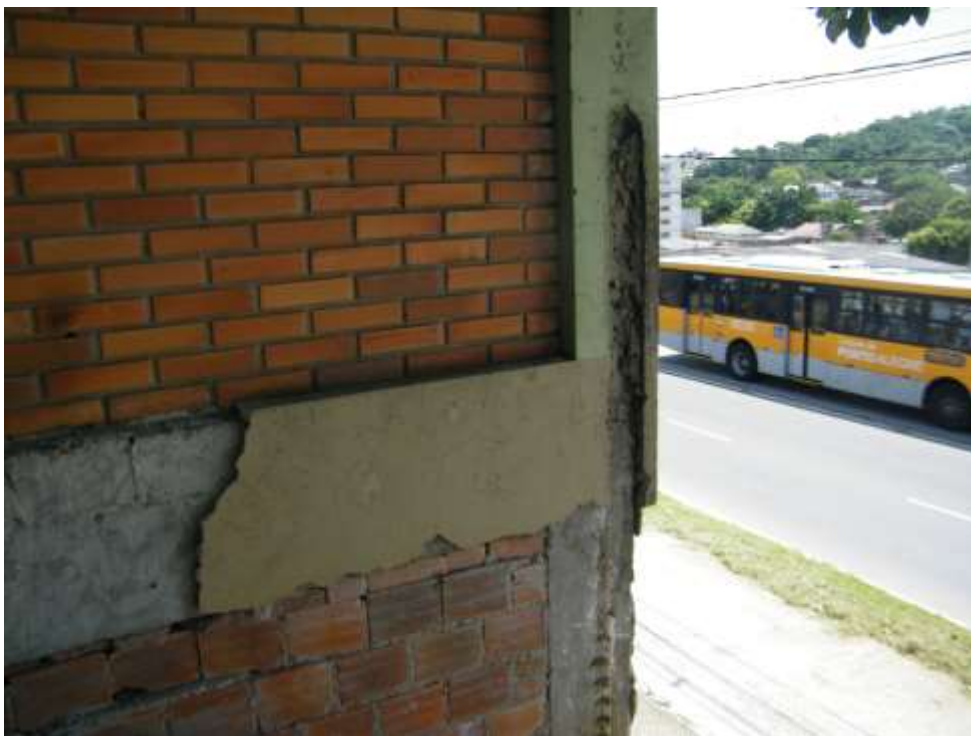
Foto 30 – Deslocamento do Revestimento na Alvenaria e Pilar.
