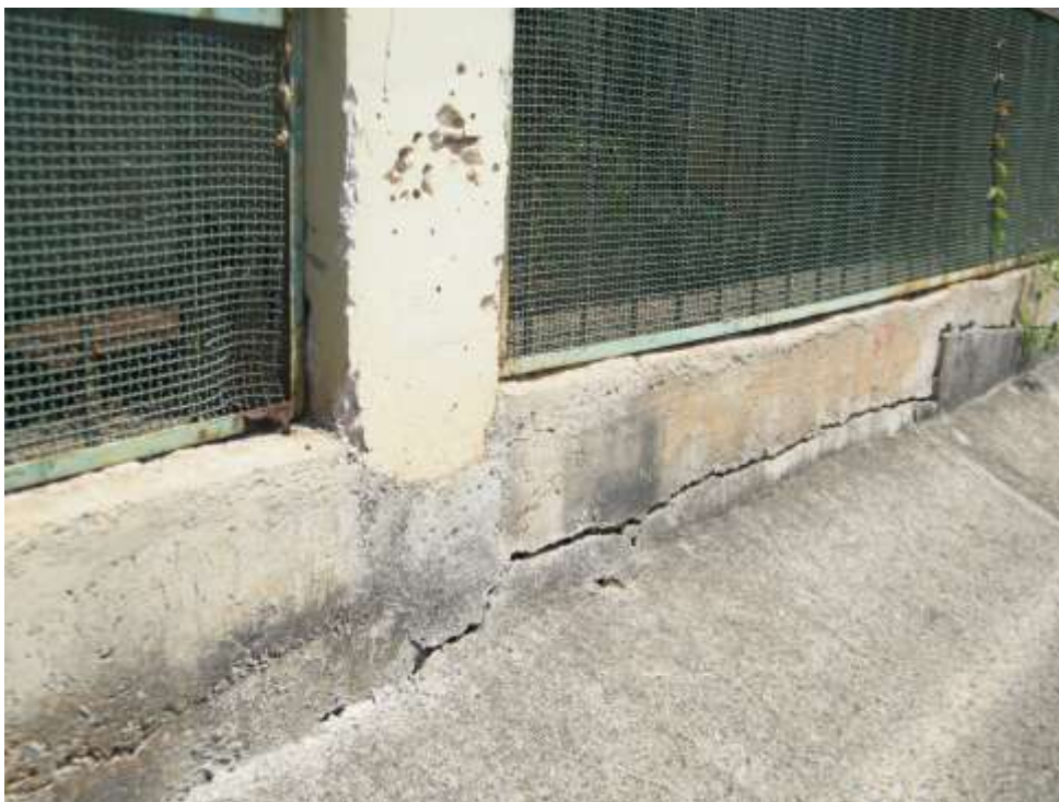
Foto 35 – Fissura Ocasionado pelo Recalque do Talude.
