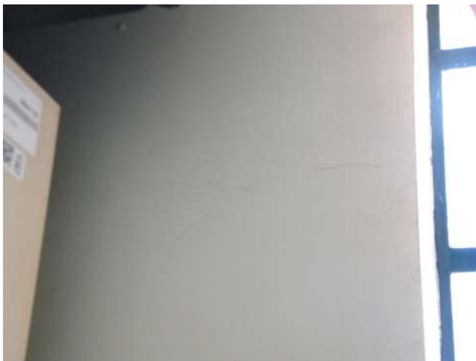
Foto 15 – Fissuras Característica Recalque na Fundação.
