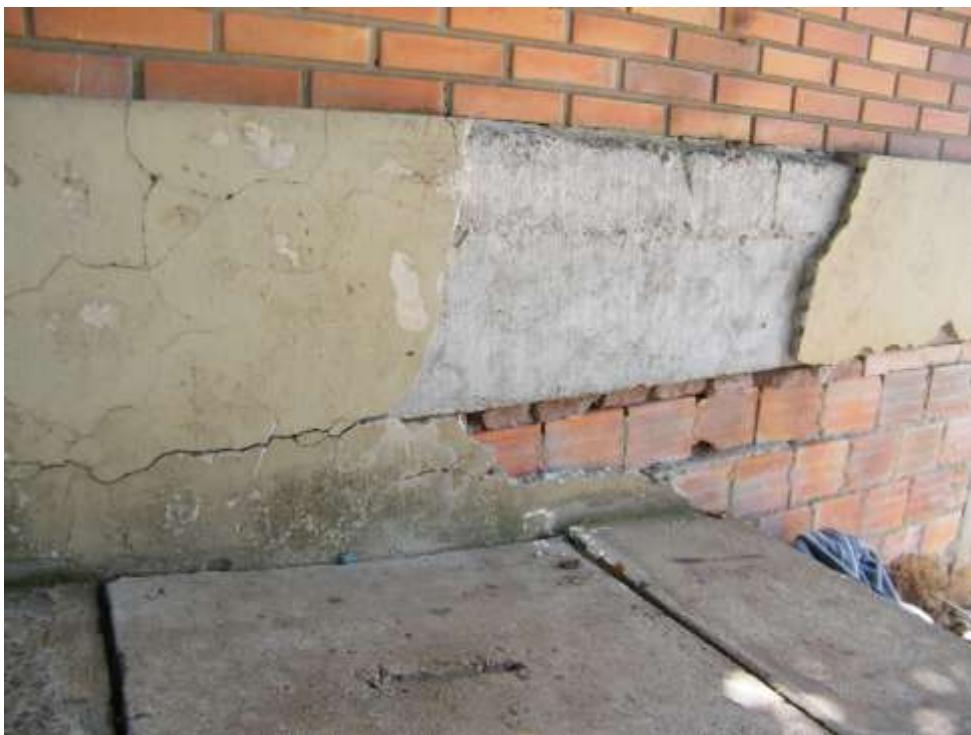
Foto 31 – Fissuras e Desplacamento no Revestimento da Alvenaria e Viga.
