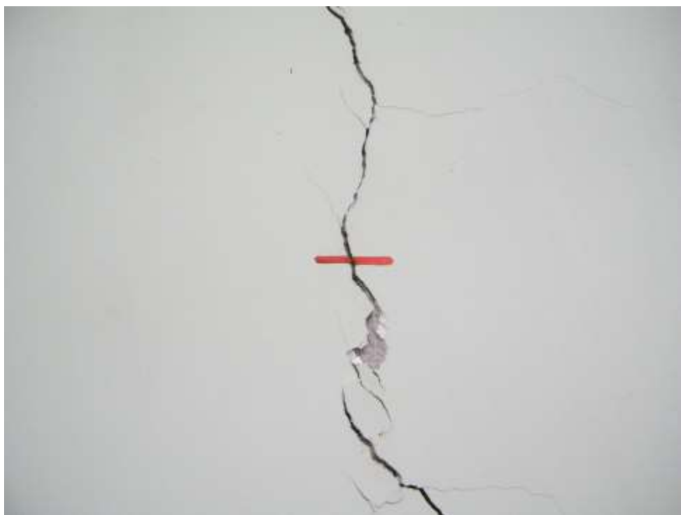
Foto 22 – Fissuras devido Expansão Térmica da Laje.
