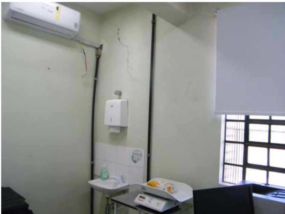
Foto 20 – Fissuras devido Expansão Térmica da Laje.
