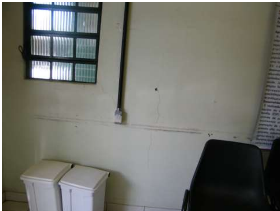
Foto 13 – Fissuras Característica Recalque na Fundação.
