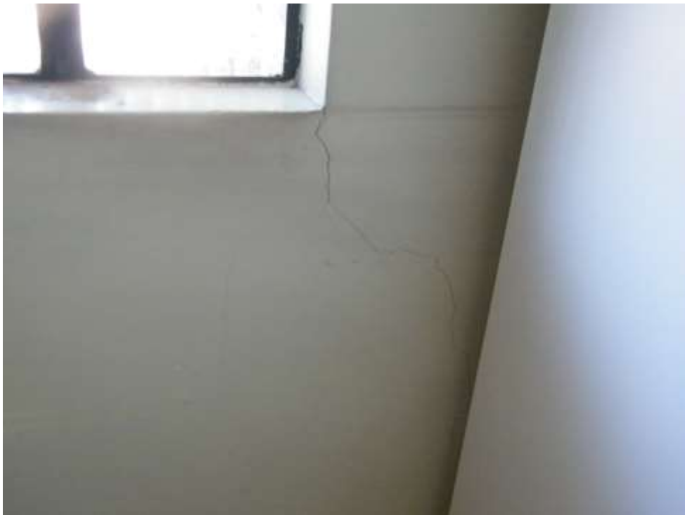
Foto 19 – Fissuras Devido Sobrecarga.
