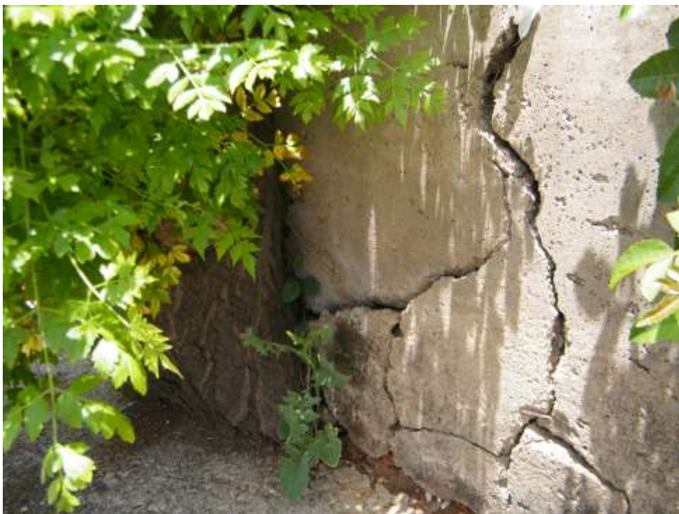
Foto 39 – Fissuras Ocasionado Pela Árvore Cinamomo e Recalque nas Fundações.
