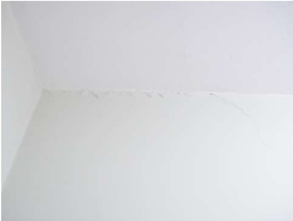
Foto 25 – Fissuras devido Expansão Térmica da Laje.
