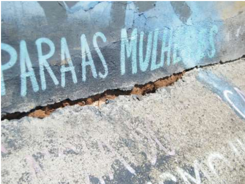
Foto 36 – Fissura Ocasionado pelo Recalque do Talude.
