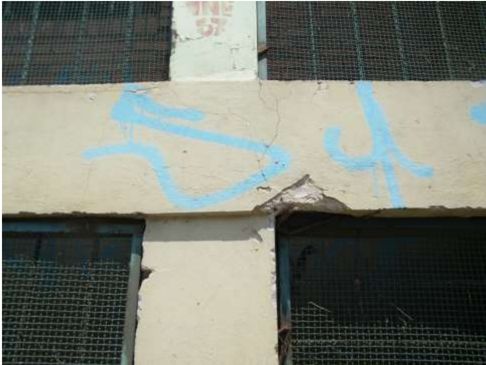
Foto 47 – Fissuras Seccionando Viga.
