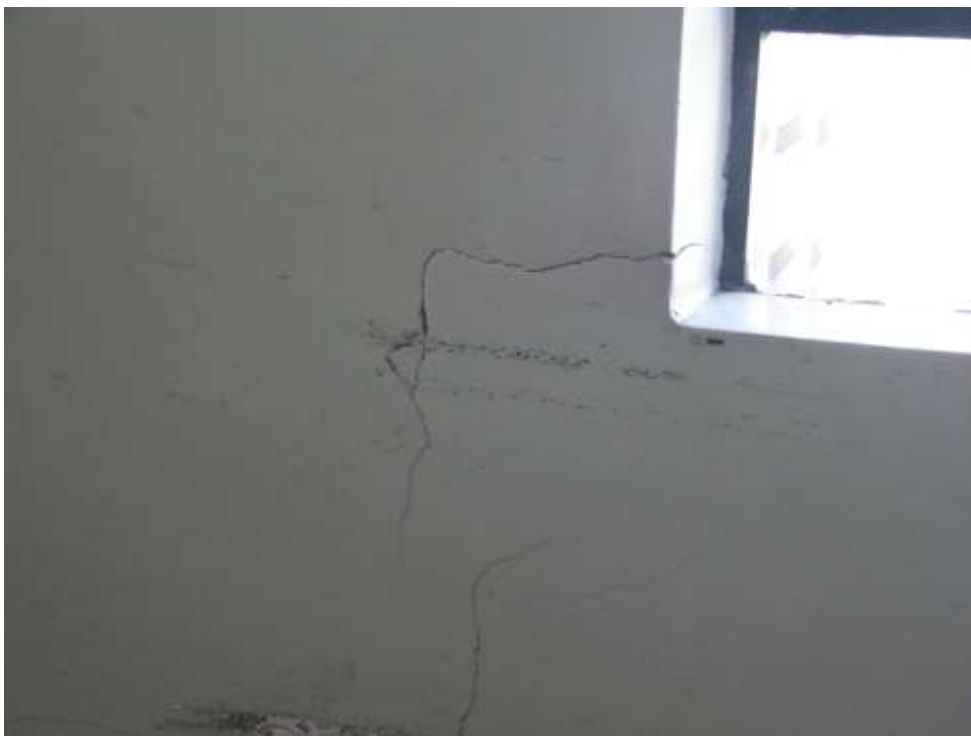
Foto 04 – Fissura Devido Diferença de Sobrecarga.
