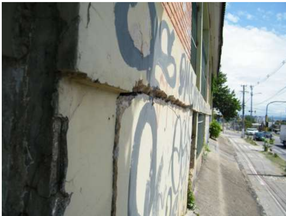
Foto 33 – Desaprumo e Desprendimento da Alvenaria.
