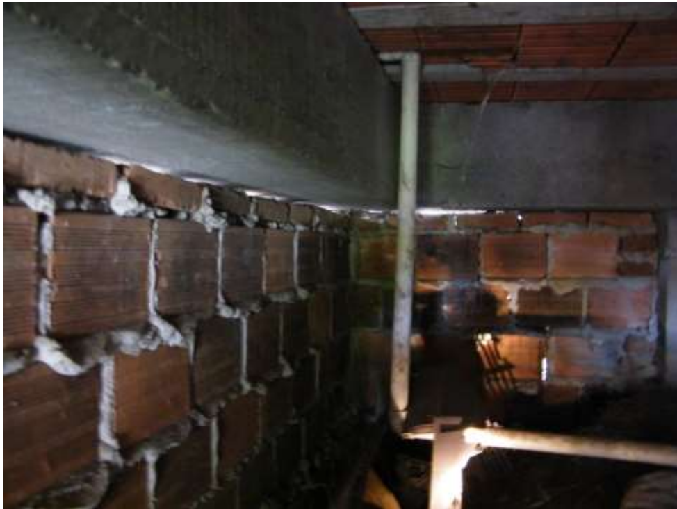
Foto 43 – Fissuras Entre Alvenaria e Viga Concreto.
