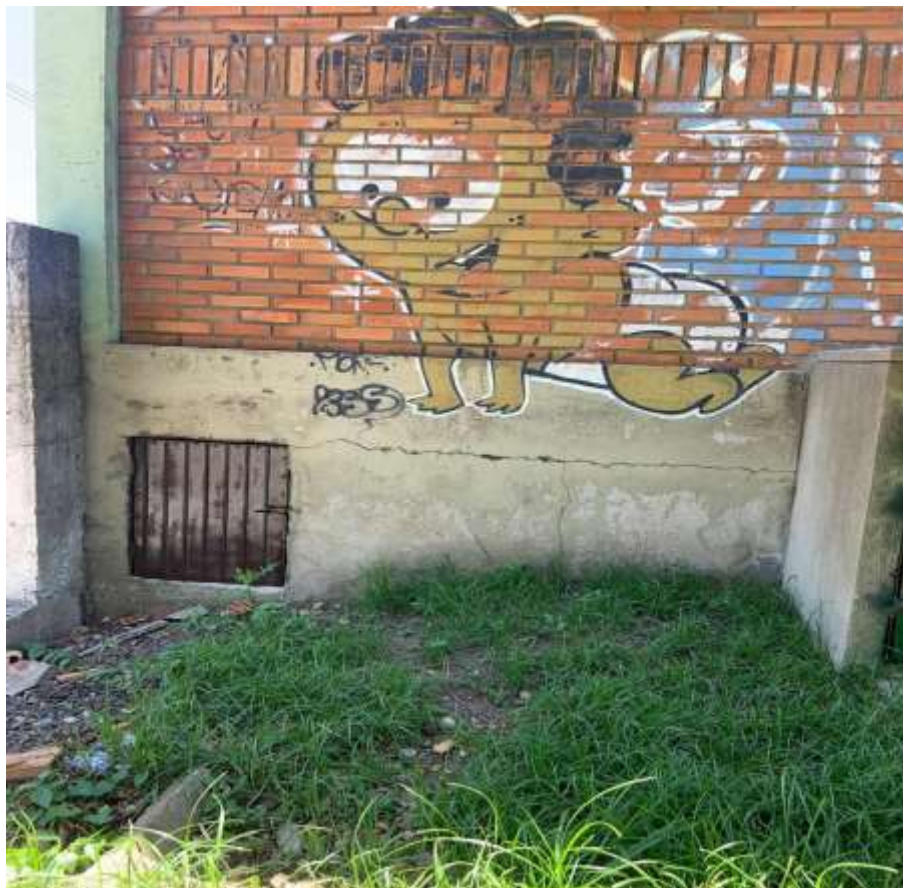
Foto 45 – Fissuras Seccionando o Pilar.
