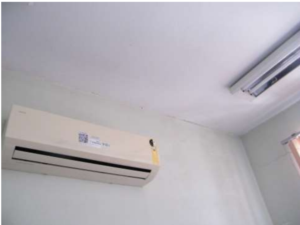
Foto 26 – Fissuras devido Expansão Térmica da Laje.
