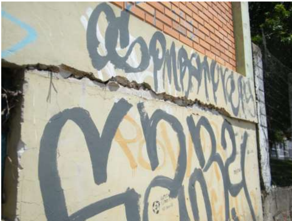
Foto 41 – Fissuras Ocasionado Pelo Recalque nas Fundações.
