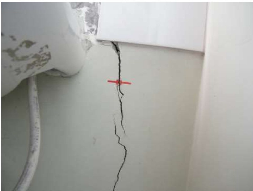
Foto 28– Fissuras Devido Recalque das Fundações.
