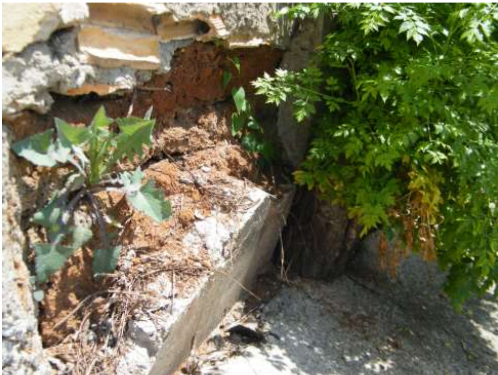
Foto 37 – Árvore Cinamomo no Meio das Estruturas e Alvenaria.
