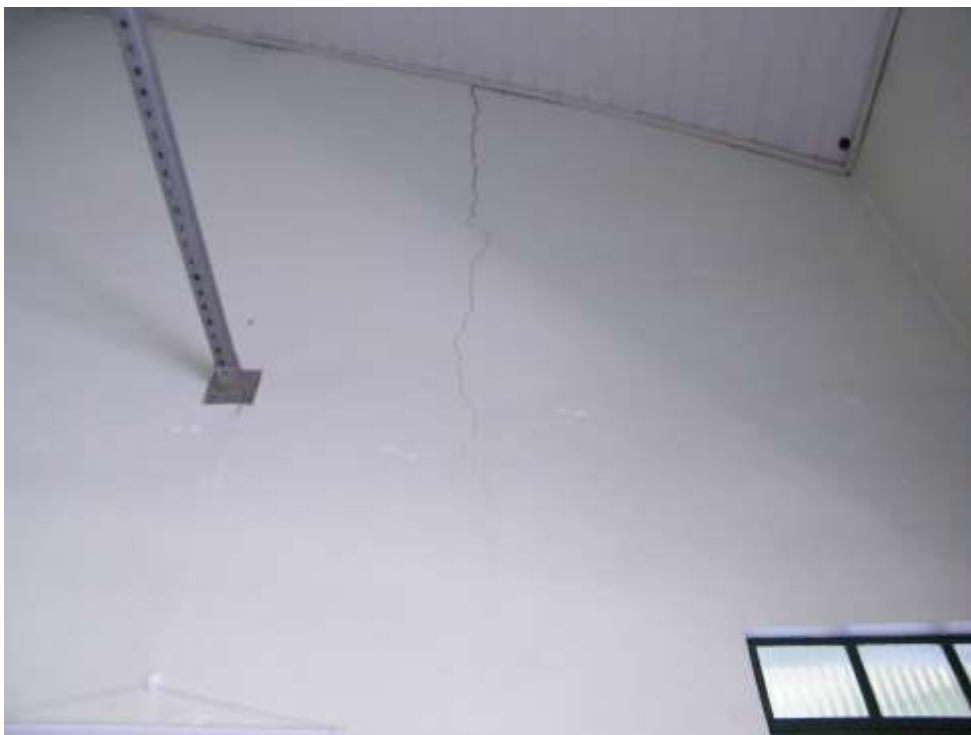
Foto 11 – Fissuras Característica Recalque na Fundação.
