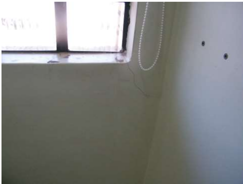
Foto 21 – Fissuras devido Expansão Térmica da Laje.
