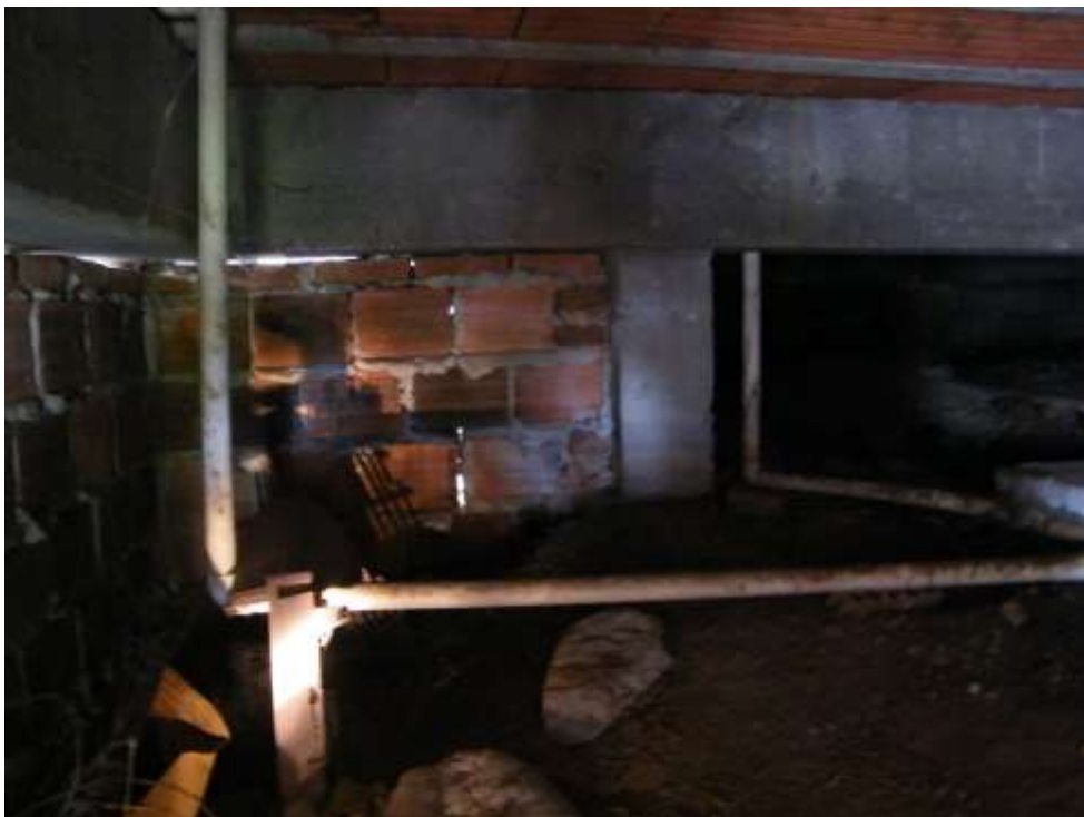
Foto 44 – Fissuras Entre Alvenaria e Viga Concreto.
