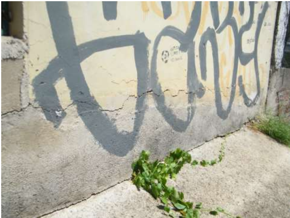
Foto 40 – Fissuras Ocasionado Pelo Recalque nas Fundações.
