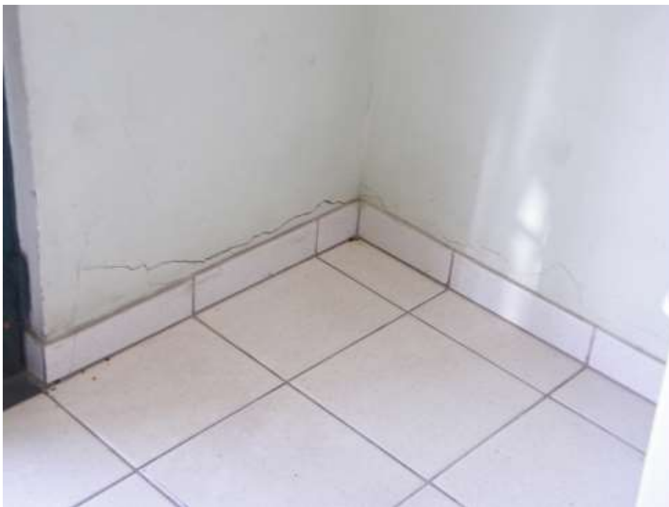
Foto 12 – Fissuras Característica Recalque na Fundação.
