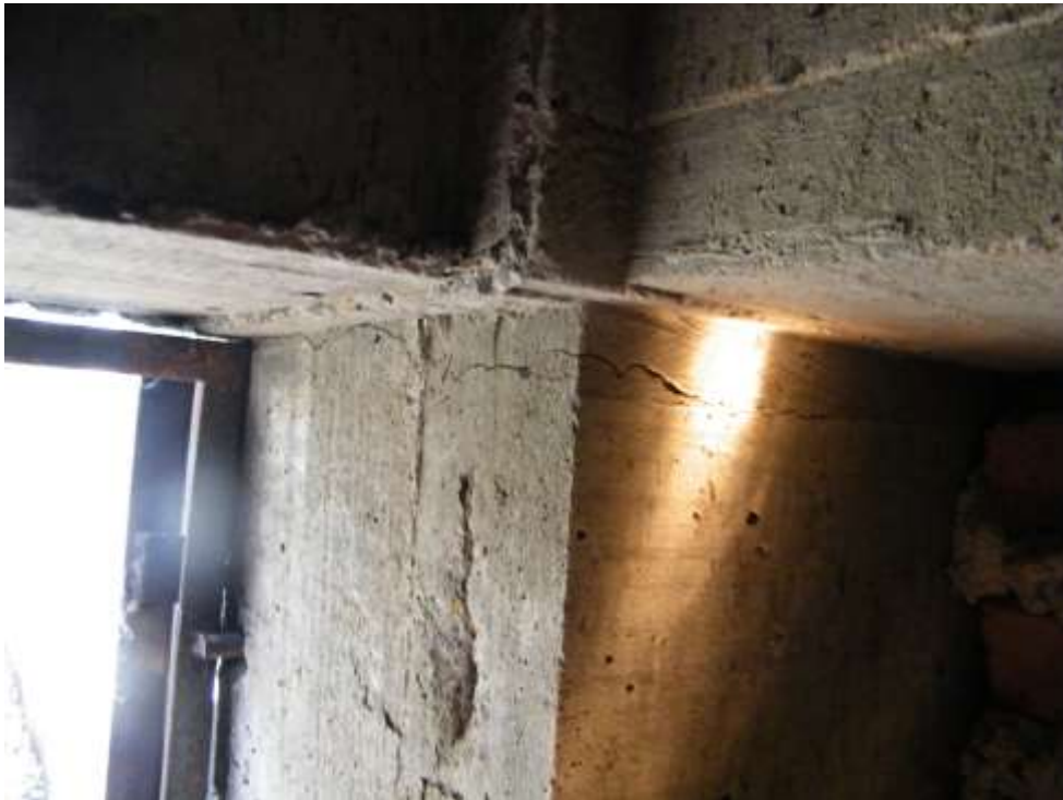
Foto 45 – Fissuras Seccionando o Pilar.
