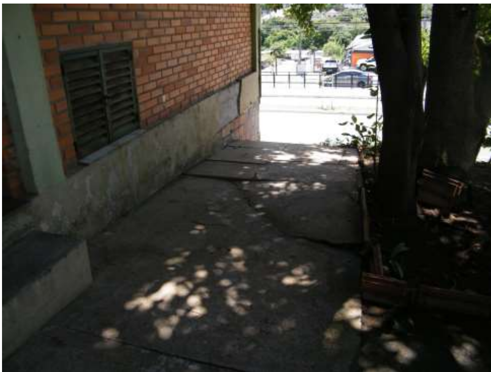
Foto 29– Deslocamento do Revestimento em Viga Baldrame.
